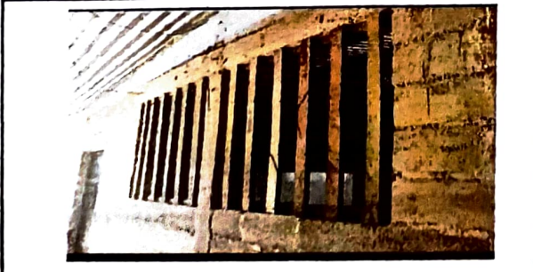
Foto 5: Se necesita de 28 ventanas de 3m X 1.50.M de 9 aulas
